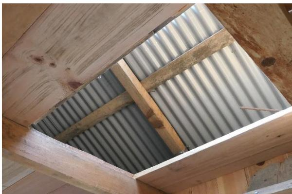
Dachkonstruktion ohne Isolation
