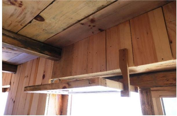
Fensterdetail eines Anfang 2019 fertig gestellten Hauses in Lumsa: Vierkantrahmen ohne Falz und ohne Dichtung, Einfachglas, 2 gerollte Scharniere und ein einfacher Hebelverschluss innen mit intelligenter Holzkonstruktion zum Offenhalten des Oberlichts.
