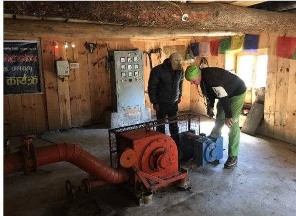
7 kW Wasserturbine und 15 kW Generator
